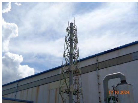
ภาพที่ 2-1 Pickling Fume Exhaust Scrubber System
