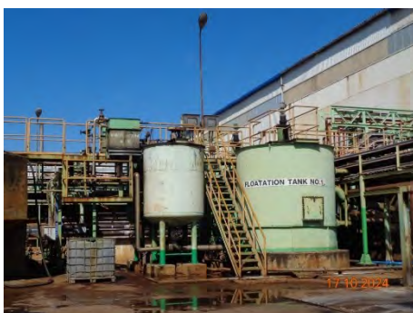
ภาพที่ 2-24 ระบบบำบัดน้ำเสียแบบเคมี และระบบแยกน้ำมันในส่วนของการบำบัดน้ำเสียแบบเคมี
