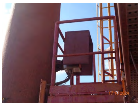
ภาพที่ 2-7 HCl Detector ติดตั้งไว้บริเวณปล่อง ARP
