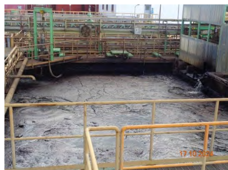
ภาพที่ 2-24 ระบบบำบัดน้ำเสียแบบเคมี และระบบแยกน้ำมันในส่วนของการบำบัดน้ำเสียแบบเคมี
