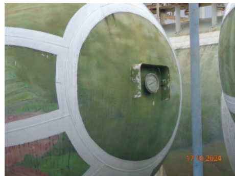
ภาพที่ 2-63 อุปกรณ์ตรวจวัดระดับหรือปริมาตร ของก๊าซแอลพีจี
