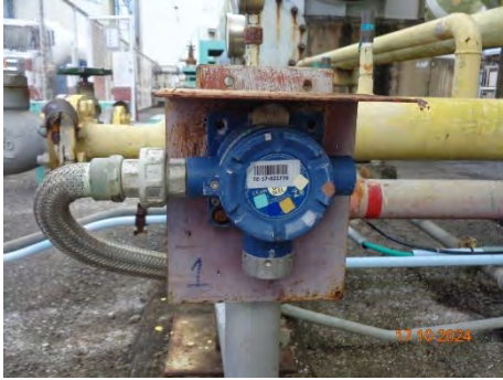
ภาพที่ 2-66 Gas Detector ในบริเวณพื้นที่ถังก๊าซแอลพีจี
