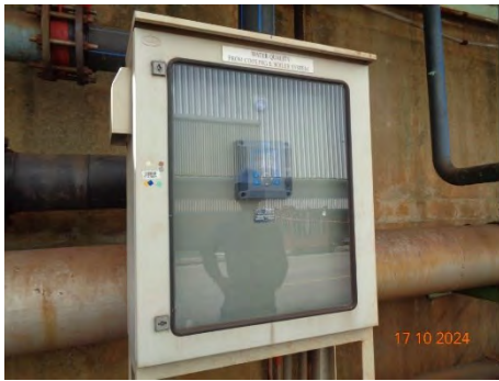
ภาพที่ 2-74 ระบบ DO Monitoring Online ป้อนตรวจสอบน้ำเข้าจากหอหล่อเย็น
